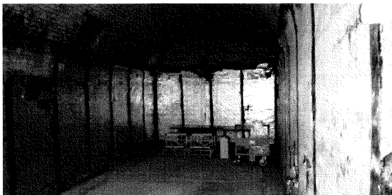
旧製麴室・工事前
